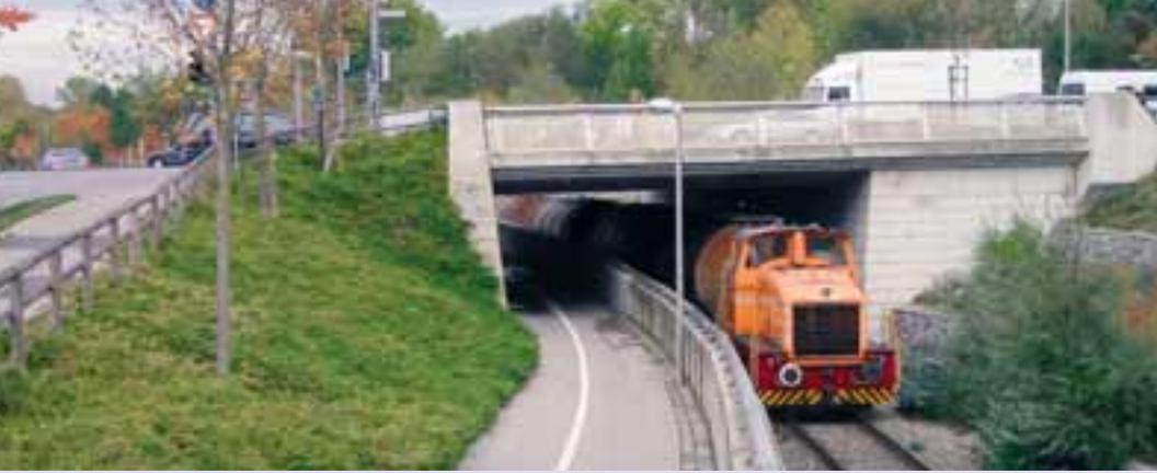
Durch die höhenfreie Ausführung der Kreuzungen mit der Berliner Allee und der Lokalbahn können sowohl Verkehrssicherheit als auch Leistungsfähigkeit gewährleistet werden.
