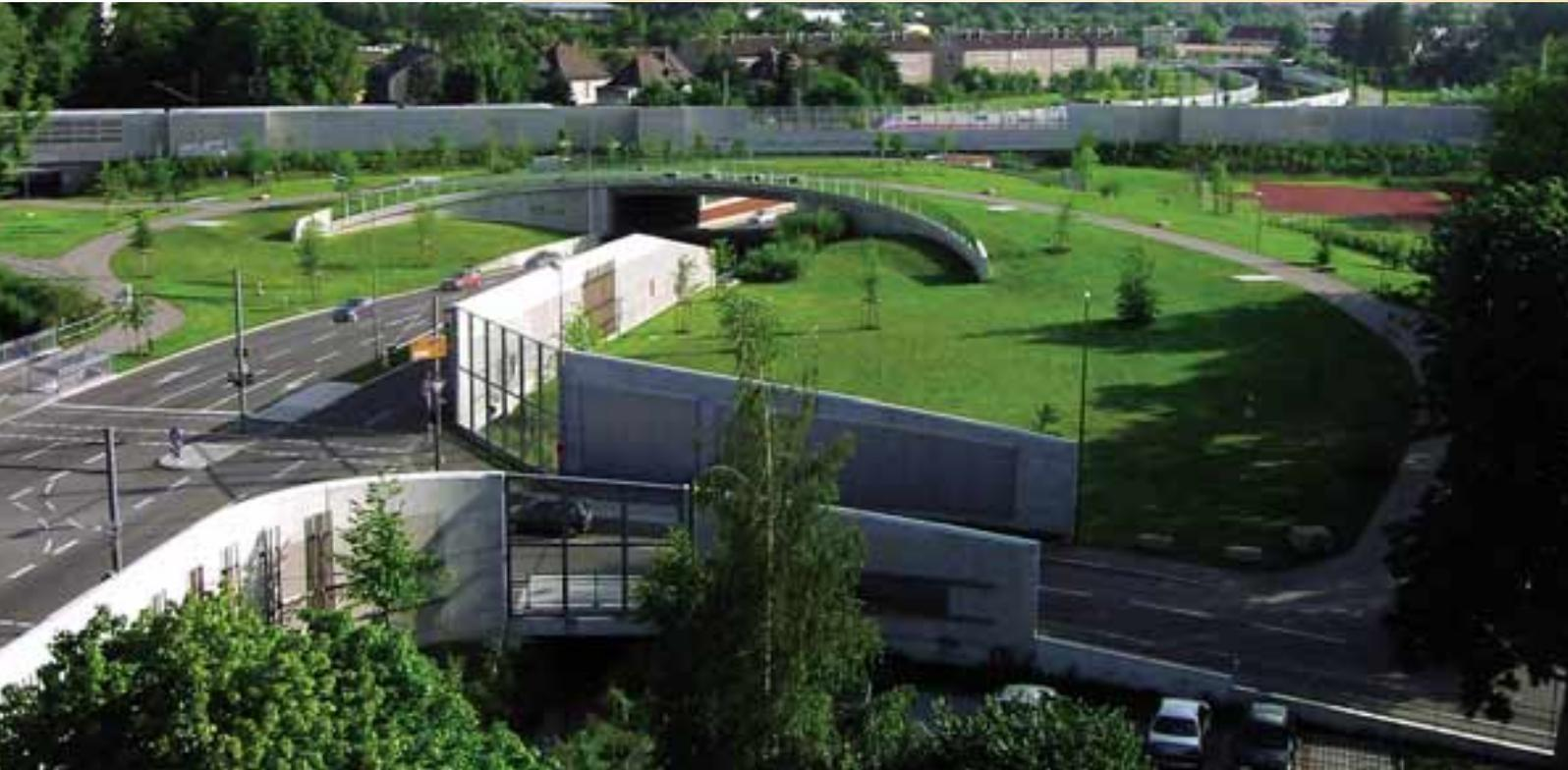
Mit dem Bau einer großzügigen Biotopbrücke wurde die Grünvernetzung der Siebentischanlagen ermöglicht.
