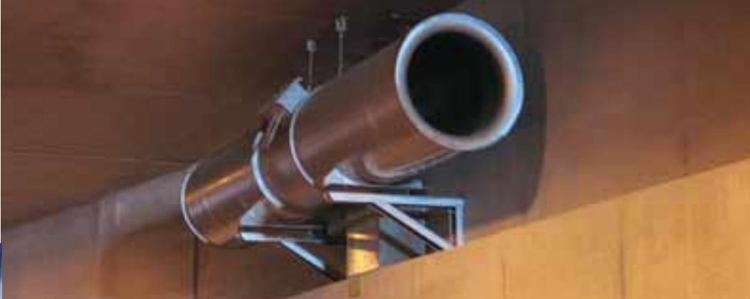
8 Strahlenventilatoren sorgen für Frischluft.
