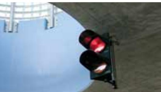
Durch Ampeln kann der Tunnel im Notfall gesperrt werden. Über Antennen wird Notfallfunk in den Tunnel übertragen.
