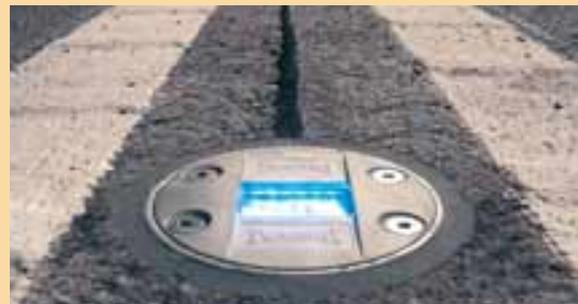
Von oben: Leitwarte in Betriebsgebäude, Videoüberwachung an den Portalen, optische Leiteinrichtungen in der Fahrbahn
