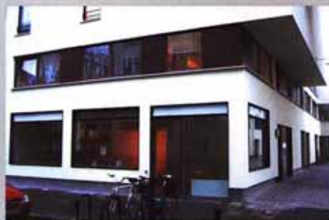
Ladenlokal im Erdgeschoss
