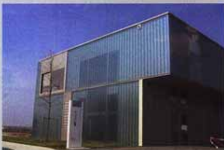
doppelschalige Glaselemente, Sichtbeton
