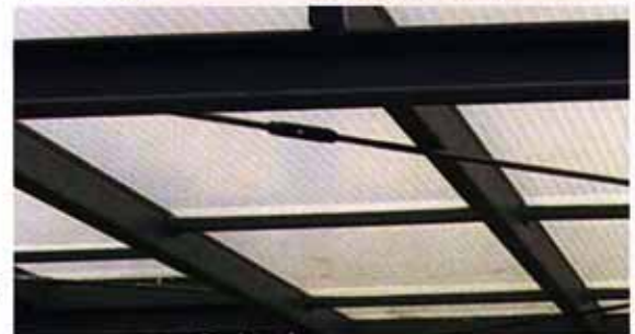
Carport aus Stahl mit Glasdach
