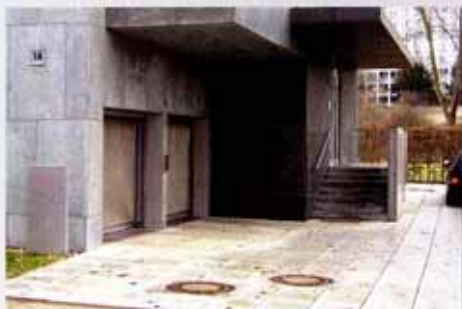
Tiefgarageneinfahrt 2 im Haus
