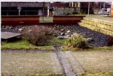
Regenwasser-Versickerung im Geschosswartungsbereich
