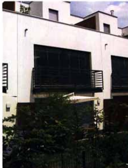
dunkelgrau lackiertes Metall für Treppengeländer, Briefkasten, Mülltonnenschutz, Dachfenster, Brüstungen
