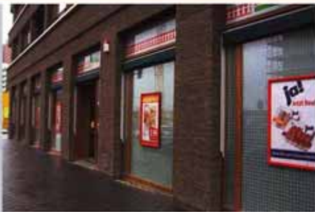
Erdgeschoss eines Supermarktes
