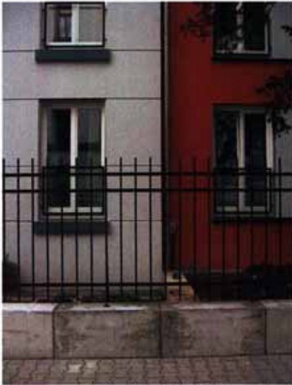
schwarzgrau lackiertes Metall für Zaun, Vordach, Leuchten, Mülltonnenschrank, Brüstungen
