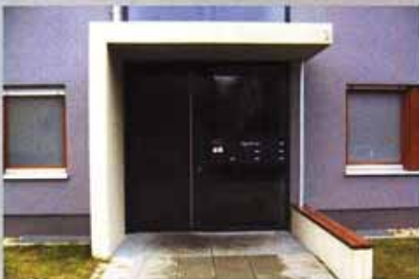
Eingangszone mit Vordach und Bank
