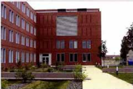
Regenwasser-Versickerung im Innenhofbereich
