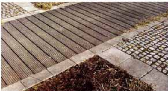
Weg aus Holzbohlen und Granitkleinpflaster mit Graniteinfassung
