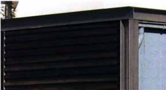
Gartenhaus aus Stahlkonstruktion mit Holzlamellen
