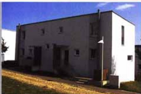
Passivhaus mit Lüftungsanlage
