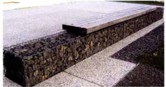
Gabione (Drahtkorb mit Steinfüllung) mit Sitzbank
