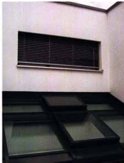
dunkelgrau lackiertes Metall für Treppengeländer, Briefkasten, Mülltonnenschutz, Dachfenster, Brüstungen
