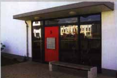
Treppenhaus mit großzügigen Abstellmöglichkeiten für Kinderwagen etc.
