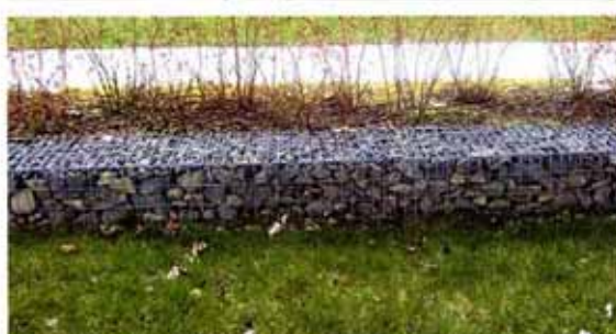
niedrige Gabionenmauer als Begrenzung
