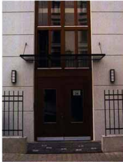
schwarzgrau lackiertes Metall für Zaun, Vordach, Leuchten, Mülltonnenschrank, Brüstungen
