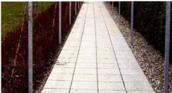
Weg aus quadratischen Betonplatten mit Pergola
