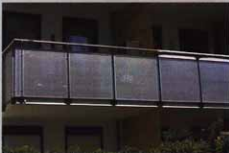
Sichtschutz durch halbtransparente Lochbleche
