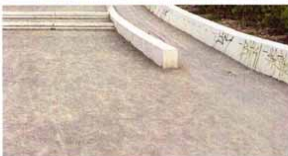
wassergebundene Decke mit Betonstufen und -kanten
