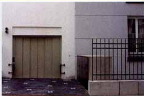
Tiefgarageneinfahrt im Haus
