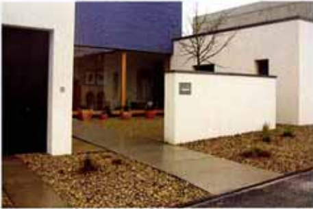
Freifläche auf Hof-Schichtfläche
