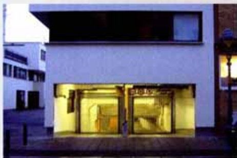
Tiefgarageneinfahrt im Haus
