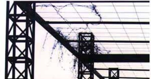
Pergola aus Stahl
