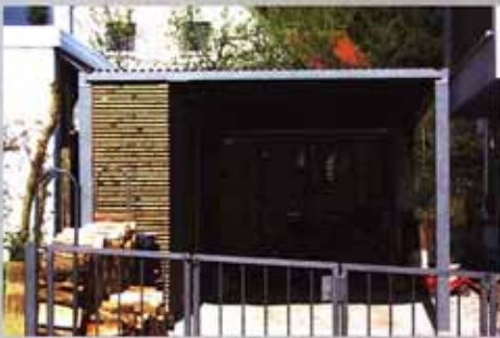
Carport als leichte Stahlkonstruktion mit Holzlamellen
