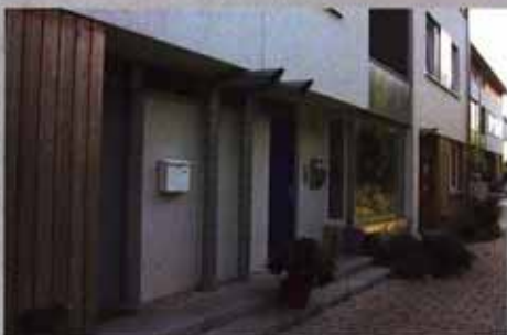
Passivhaus mit Lüftungsanlage
