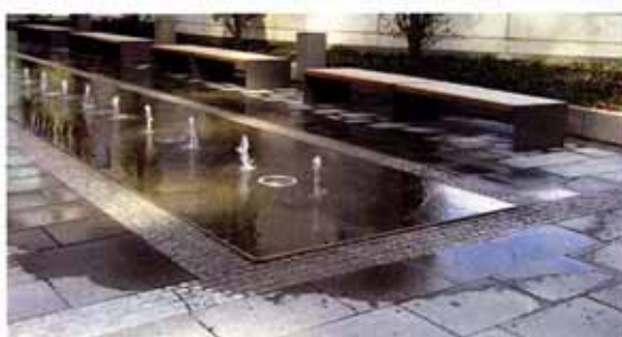
Betonplatten, Granitpflaster, Bank aus grau lackiertem Stahl und Holz
