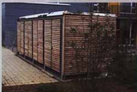
Mülltonneneinhausung aus Stahlkonstruktion mit Holzlamellen
