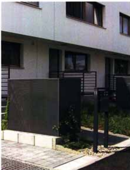
dunkelgrau lackiertes Metall für Treppengeländer, Briefkasten, Mülltonnenschutz, Dachfenster, Brüstungen
