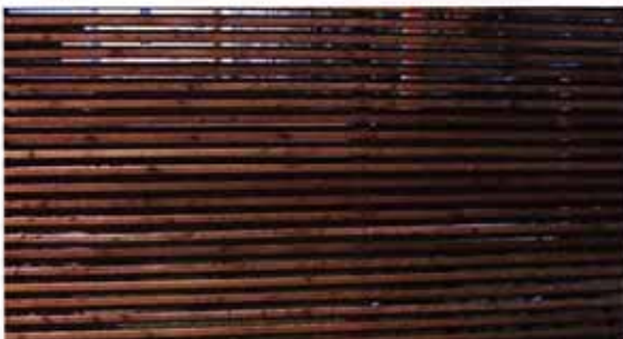
Holzverschalung am Nebengebäude
