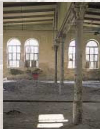
Kuka-Maschinenhalle vor den Umbaumaßnahmen
