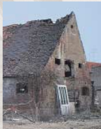
Ulrichsstadel vor der Sanierung
