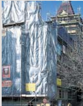
Stadtbad während der Sanierung
