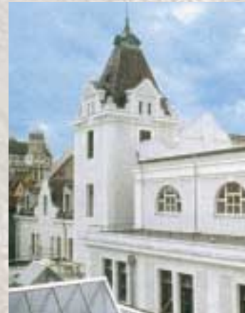
Stadtbad nach der Sanierung
