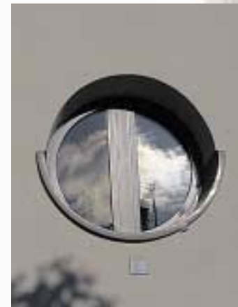
Detail des Neubaus in der Zollernstraße
