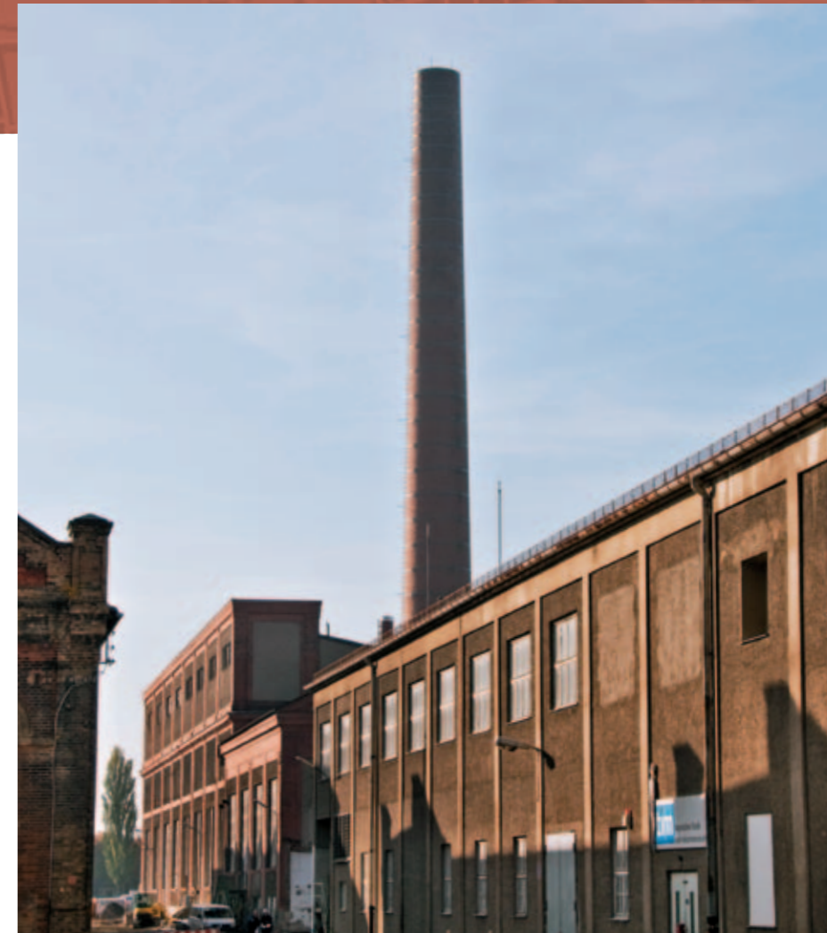
Oben: Auf dem AKS-Gelände entsteht mit dem Textilmuseum, dem neuen Archiv und der Stadtarchäologie ein »Kulturspeicher«.
