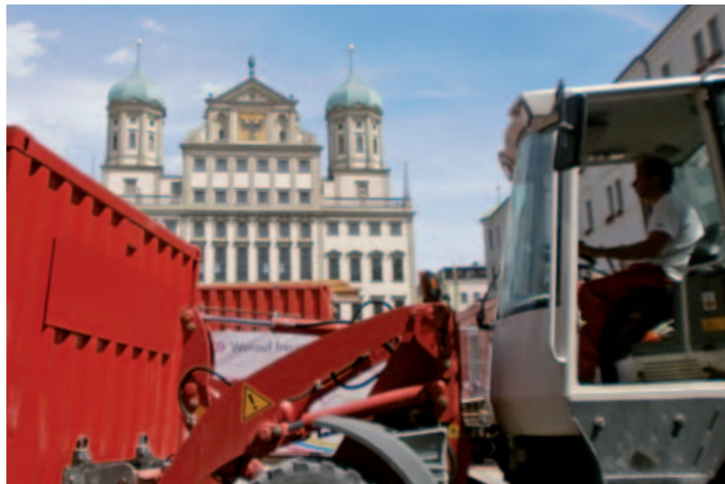
Oben: Zahlreiche Baustellen prägen derzeit das Bild der Innenstadt. Sie sind das sichtbare Zeichen der städtebaulichen Aufwertung.
