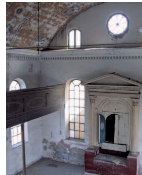
Unten: Der Innenraum der ehemaligen Synagoge in Kriegshaber vor der Sanierung.
