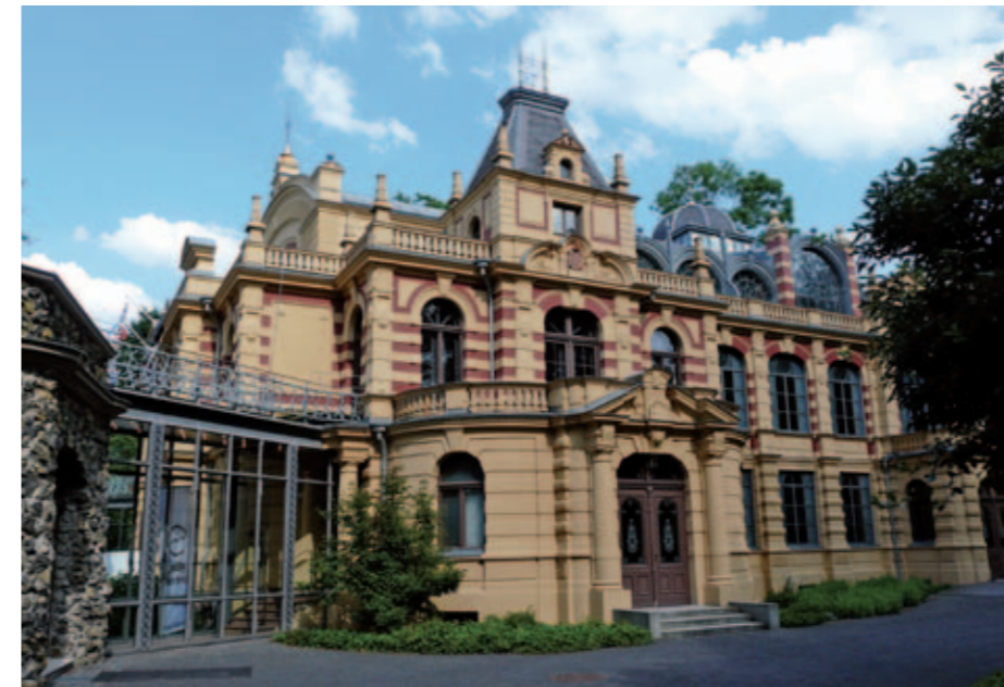
Links: Das Kurhaustheater in Göggingen nach der Sanierung.
