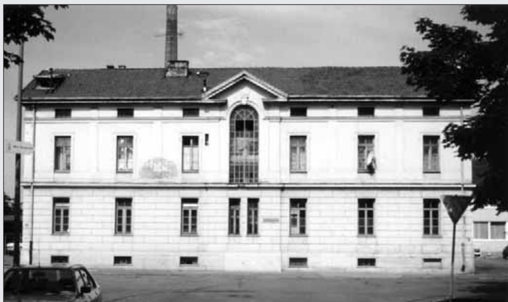
Schäfflerbachstr. 30: Wasch- und Badehaus im Kammgarnquartier (Foto: ca. 1990)
