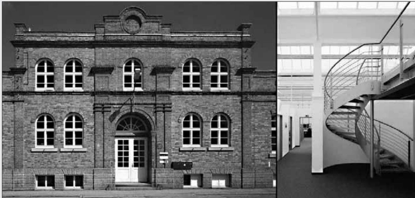
Firma Dierig, heute: Medienfabrik Augsburg (aktuelles Foto)
