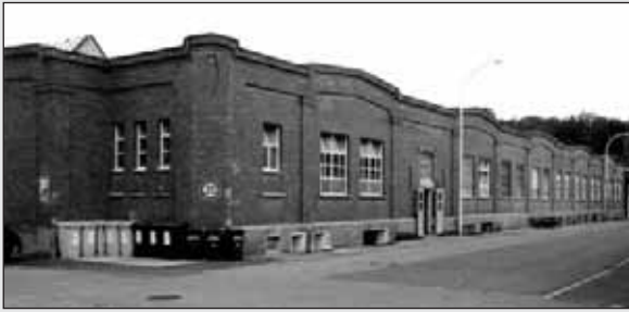
Fassade der Sched-Hallen (Foto: ca. 1990)
