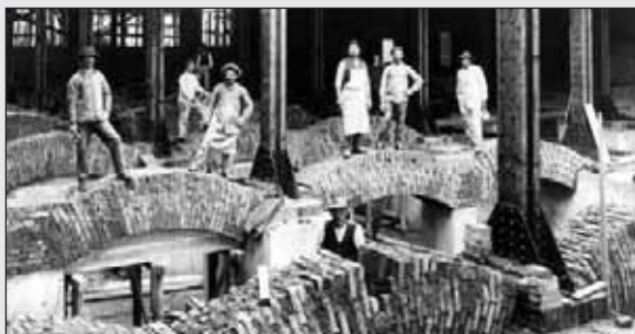
Bau der Kellergewölbe des Glaspalastes (Foto von 1909)
