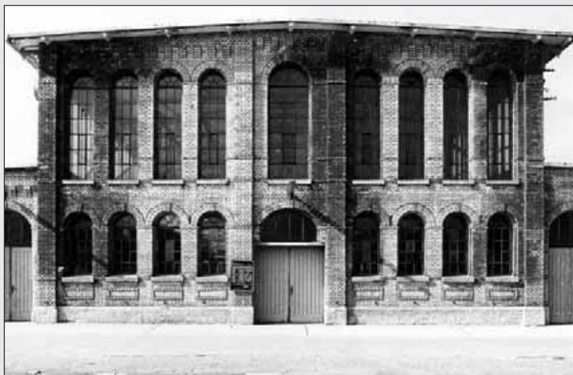
Westfassade der Kälberhalle (Foto: ca. 1990)
