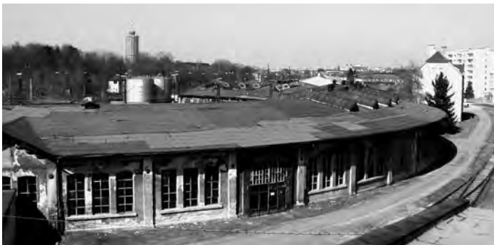
Lokschuppen: Außenansicht, aktuelle Aufnahme.
