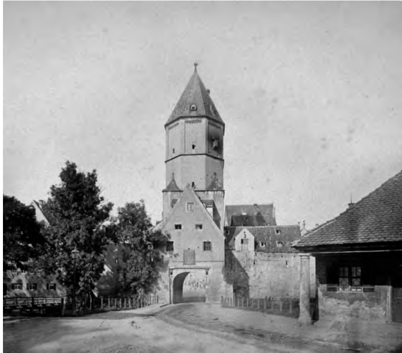
Blick von der Feldseite auf die nach Abtragung der Stadtmauer noch vollständig erhaltene Jakobertoranlage (ca. 1876)
