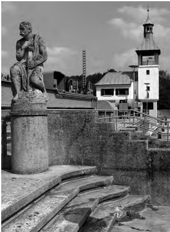
Hochablaß: Flößerdenkmal an der Wehranlage nahe der ehemaligen Floßgasse.
