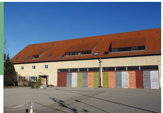
Bild B Ein Erinnerungs- und Lernort erzählt von der Geschichte der »Halle 116« und den Menschen, die hier gefangen gehalten wurden.
