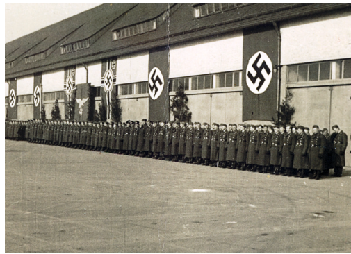
Bild A Von 1935–1937 errichtete die deutsche Wehrmacht die Luftnachrichten-Kaserne. Zu ihr gehörte auch das später als »Halle 116« bezeichnete Gebäude. Es diente vor allem als Fahrzeuggarage.
