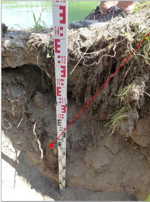
Abb. 3 Zersetzer Holzpfahl an der Betoneinfassung, Grabung 7
