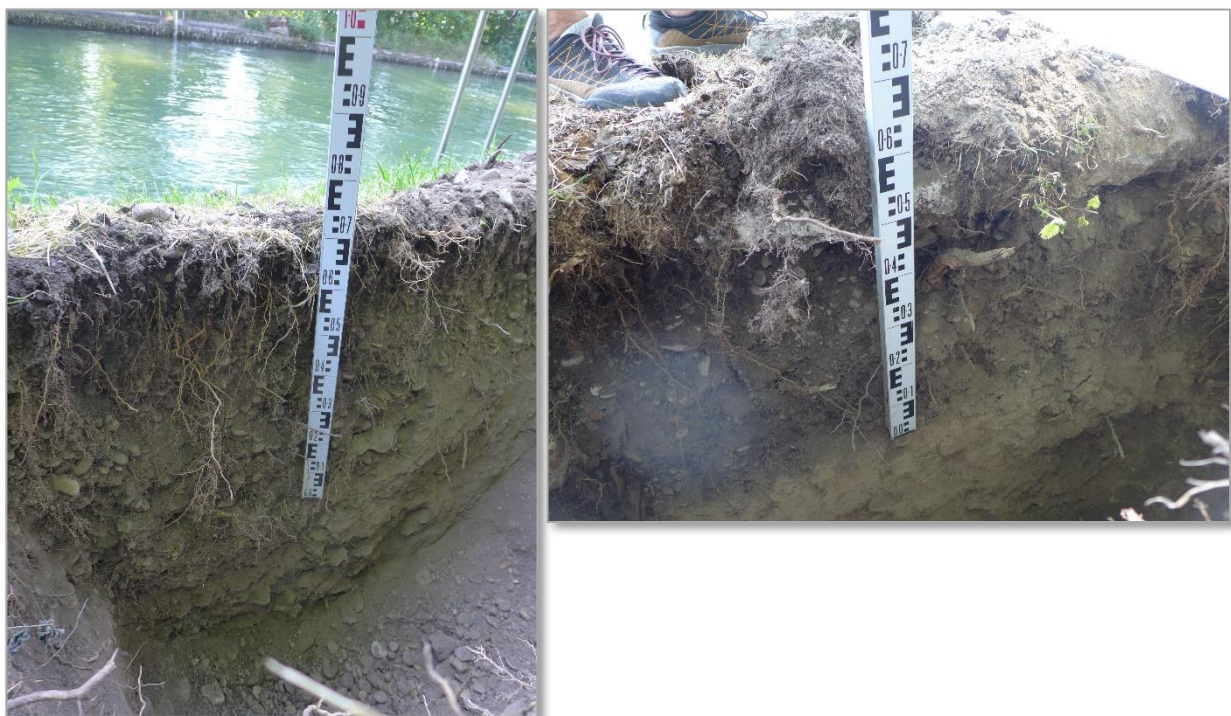
Abb. 1 Bodenschürfe Nr. 1 und 5 an der Betonmauer
