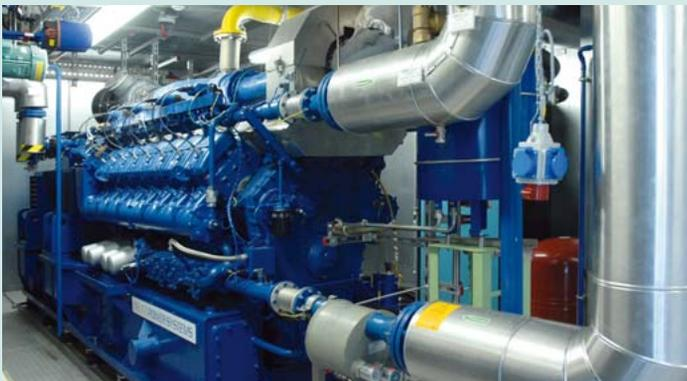
*Energiegewinnung aus Faulgas: Über ein eigenes Blockheizkraftwerk versorgt sich das Klärwerk Augsburg weitgehend selbstständig mit Strom.*
