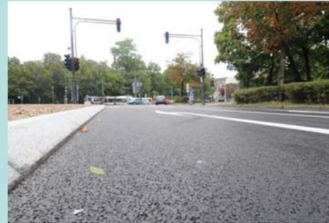
*Luftdurchlässig und leise: lärmarmes Splitt-Mastix-Belag am Roten Tor.*
