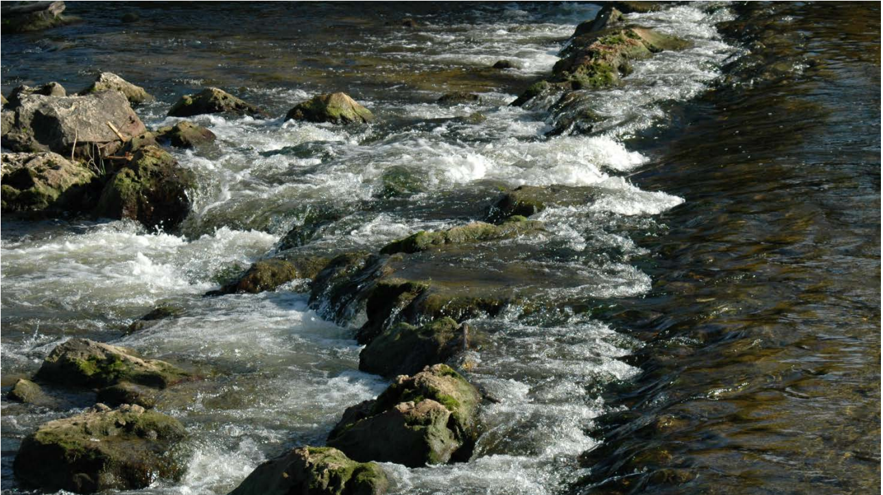
Sohlschwellen in der Wertach Quelle: Herwarth + Holz, Berlin
