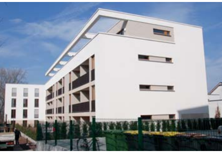
Staffelgeschoss als Dachterrasse
