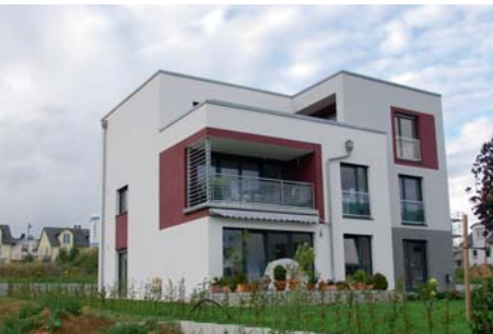
Rücksprung als Dachterrasse
