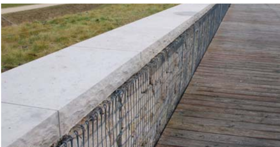
Gabione (Drahtkorb mit Steinfüllung) mit Sitzbank
