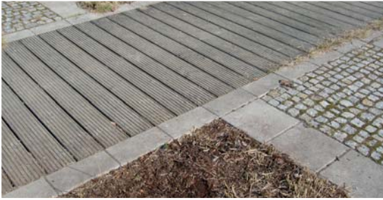
Weg aus Holzbohlen und Granitkleinpflaster mit Graniteinfassung
