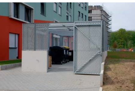
Mülltonnensichtschutz aus Streckmetall
