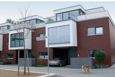
Stellplatzüberdachung durch Fassadenelmente
