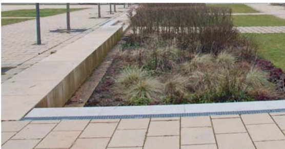
Betonplatten, Granitpflaster, Bank aus grau lackiertem Stahl und Holz
