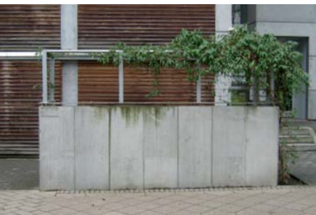
Mülltonnensichtschutz aus Sichtbeton
