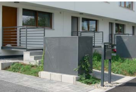
Mülltonnenbox aus grau lackiertem Stahl
