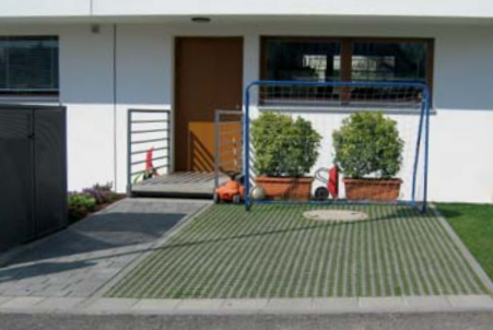
Stellplatz aus Rasengittersteinen
