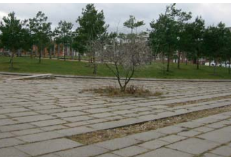
versickerungsfähiger Bodenbelag
