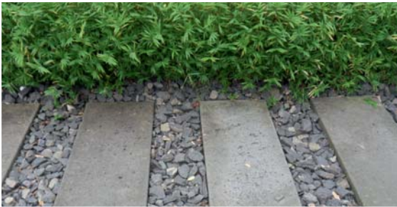
wassergebundene Decke mit Betonstufen und -kanten
