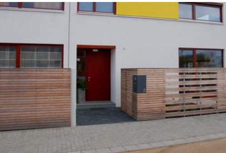
Einfriedung mit integrierter Einhausung
