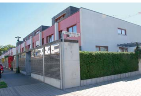
Vorzone mit Nebengebäuden
