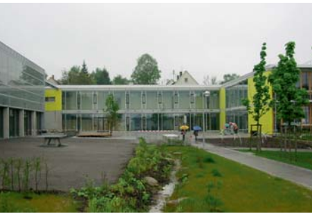
Regenwasserversickerung im Schulhof
