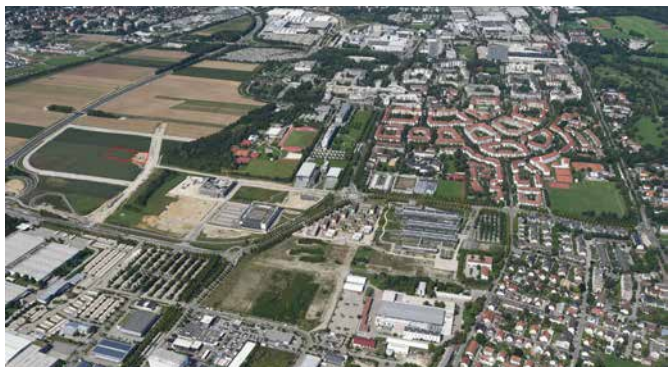
Auf dem Baufeld Nr. 34 wird baramundi seinen Hauptsitz beziehen. (Bild: Marcus Merk)
