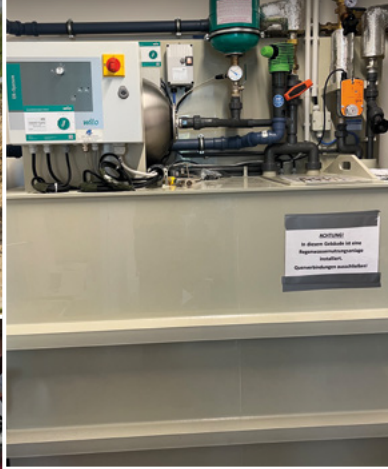
Bau einer Regenwasserzisterne für die Einsparung von Trinkwasser
