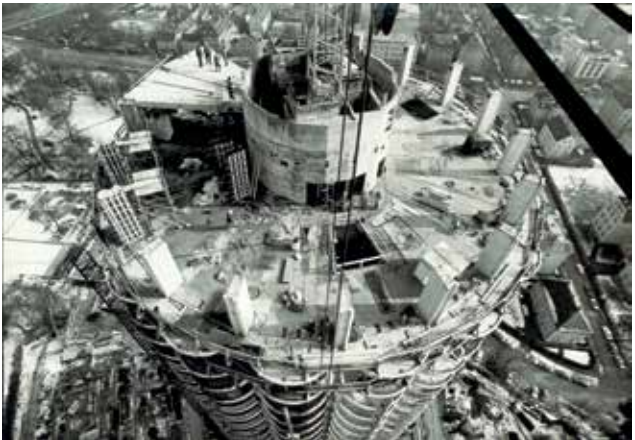
Luftbild aus der Bauphase des Hotelturms, 1971/72.
